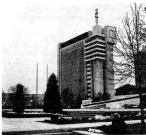
Р. Блезэ, Л. Владимирова, Н. Горбенко, О. Гришко, Л. Христинич (архитекторы). Дом печати издательства ЦК Компартии Узбекистана. 1974.
